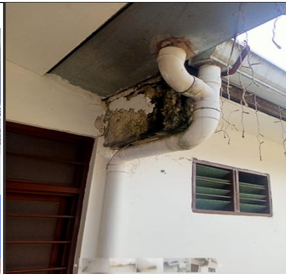
Mantenimiento de canales de agua lluvia.
