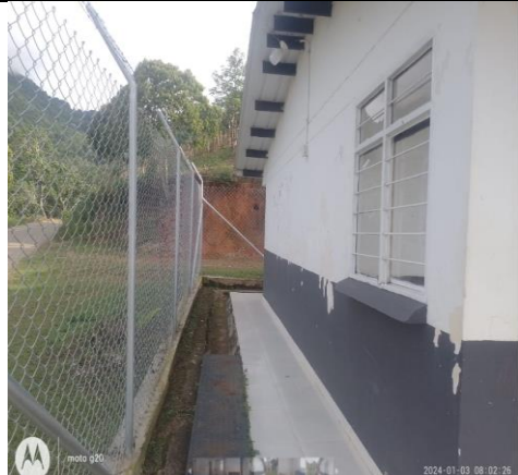
Humedad en paredes, se requiere impermeabilizar
