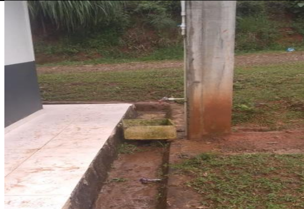
Se requiere instalar poceta adecuadamente, esta suelta.
