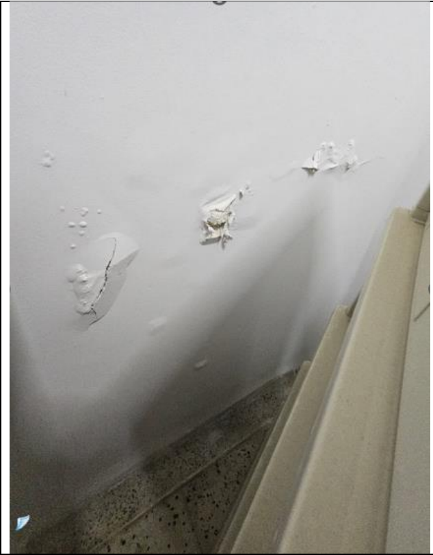
Paredes con humedad de toma de muestras de laboratorio
