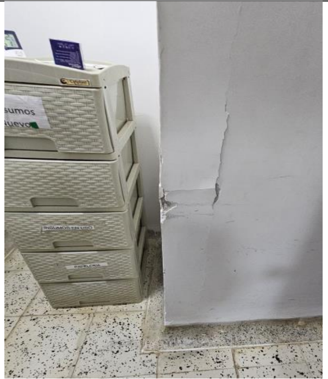
Paredes con humedad de toma de muestras de laboratorio
