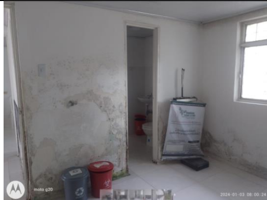
Humedad en paredes, se requiere impermeabilizar
